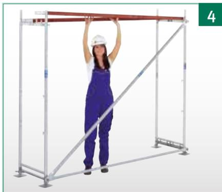
4 Beläge auflegen, Gerüstfeld mit Wasserwaage an Geländer und Rahmen lotrecht ausrichten.
