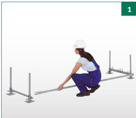
1 Fußspindeln aufstellen, Fußtraverse aufstecken, Rückengeländer einhängen (nur im Diagonalfeld).
