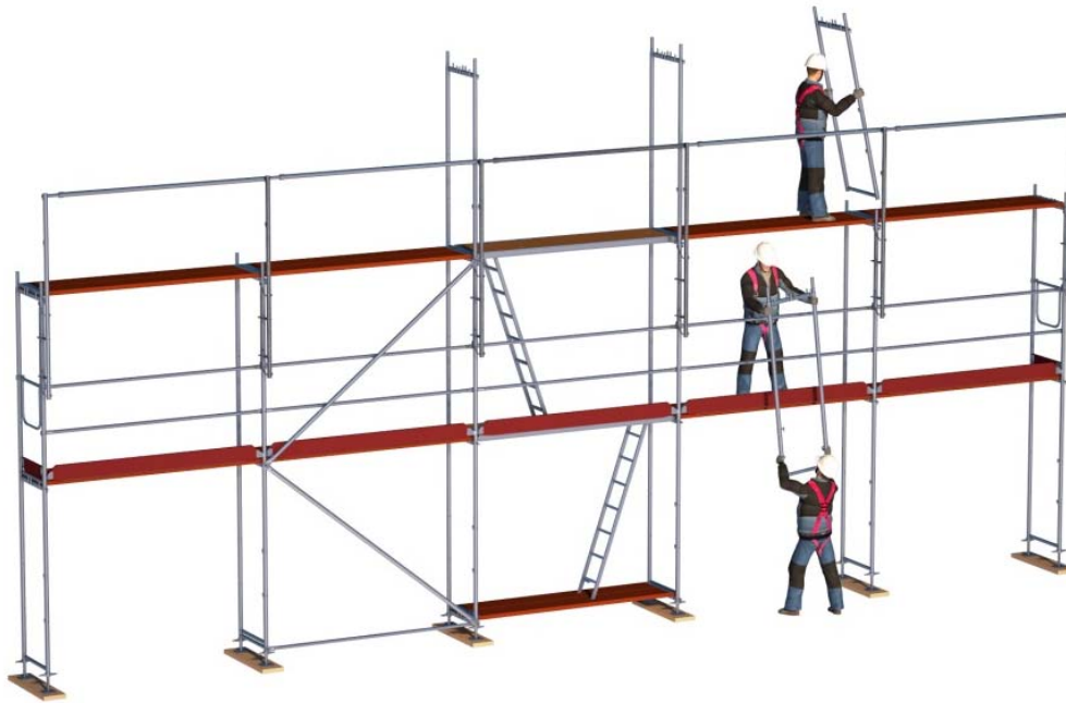
Bild 30: Montage der Gerüstlage im Schutze des MSG.
